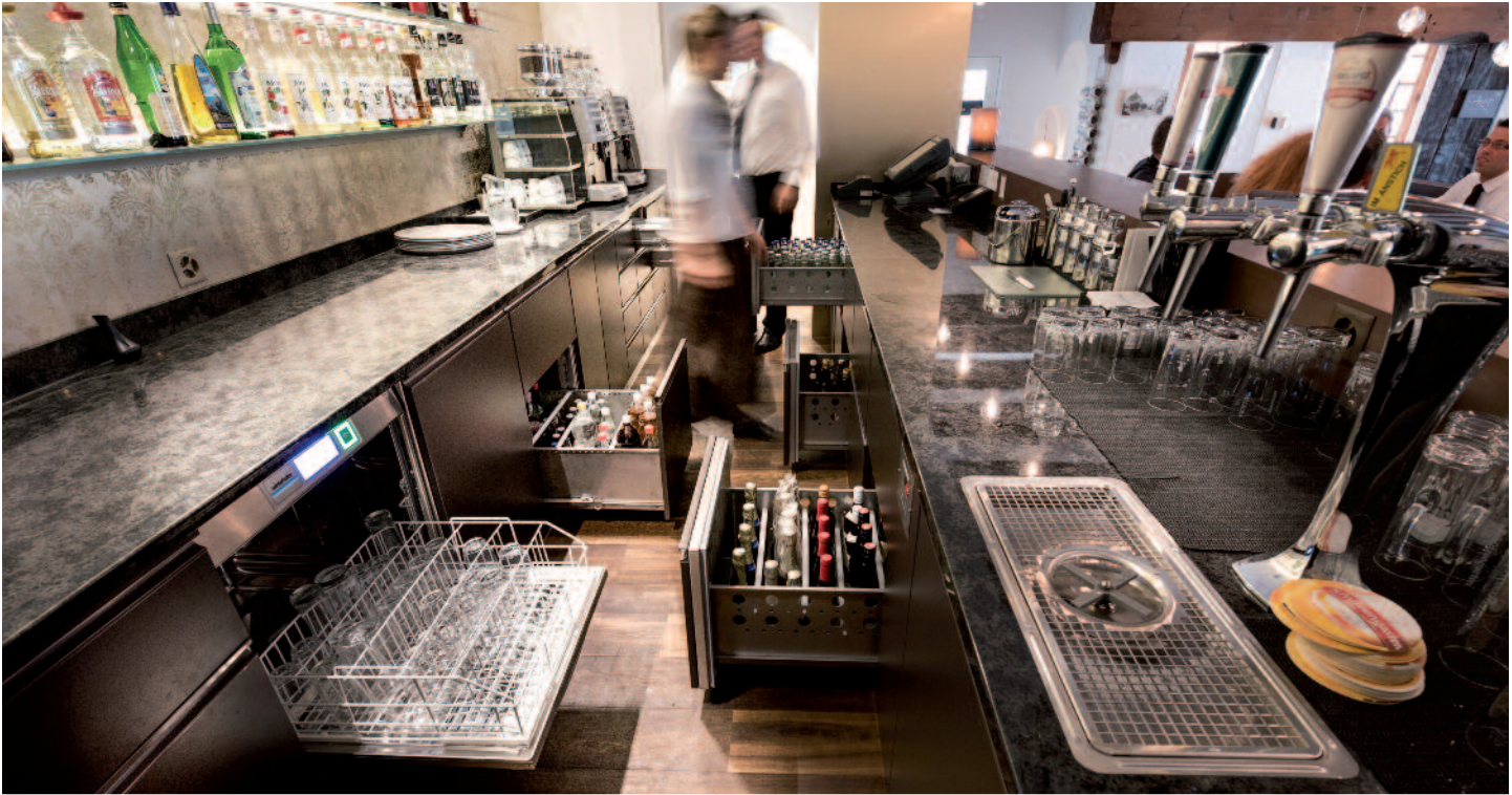
Die Spezialisten der Hugentobler AG haben die Unterbauten der Bartheke massgeschneidert konzipiert und realisiert. Die gekühlten Schubladen sind eine Spezialanfertigung.
