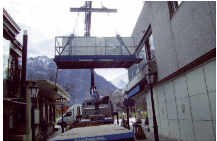
Es kommt ein Herd geflogen: Der Induktionsherd der Hugentobler AG musste mit einem Kran in die Hotelküche gehievt werden.
