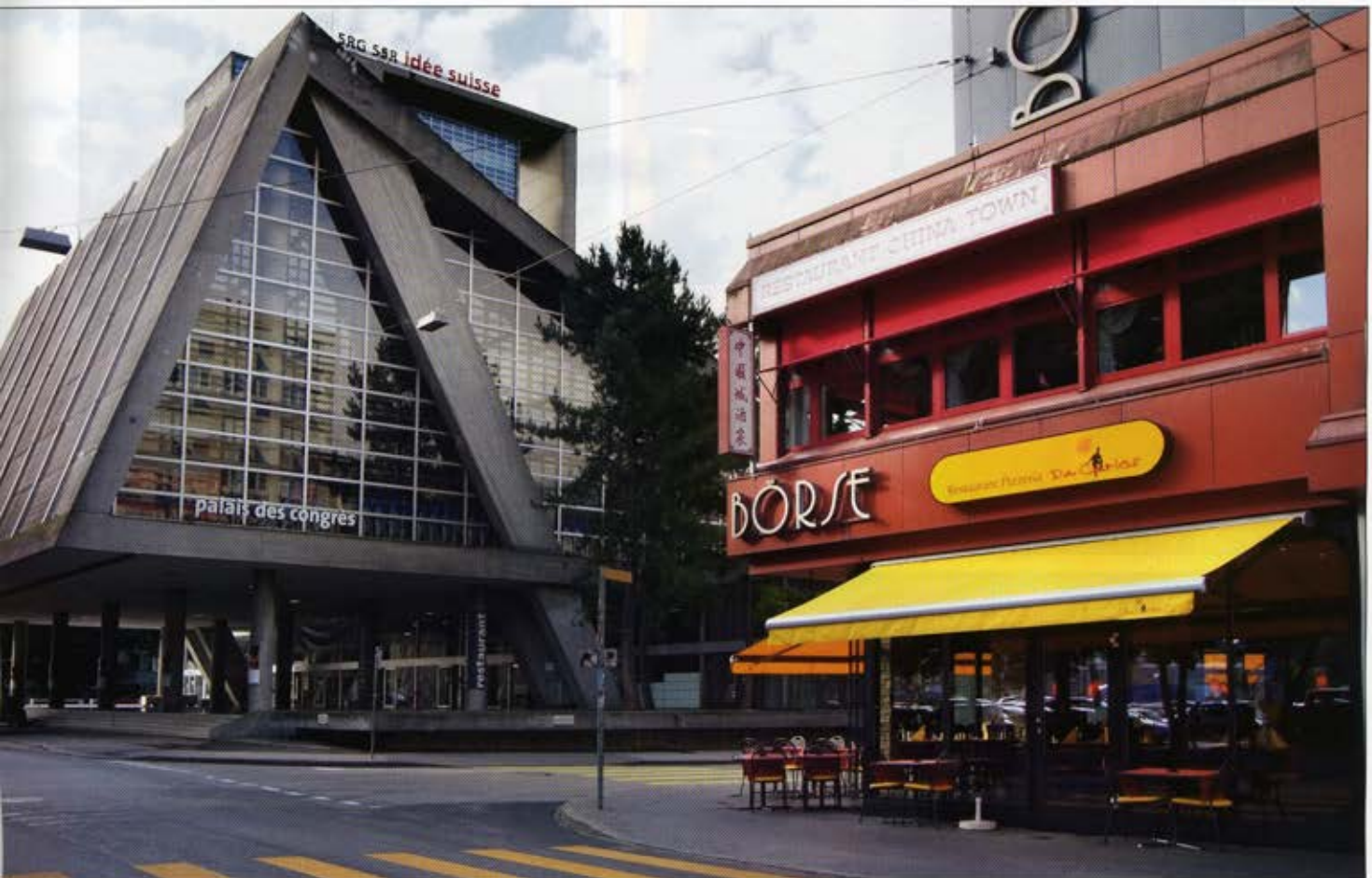
städttebaulichen Zentrum beim Kongresshaus Biel im Erdgeschoss des «Haus zur Börse».
